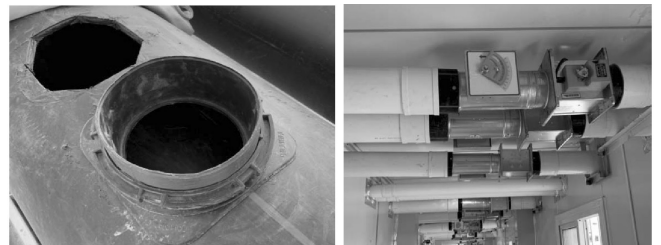
图3 PE主管开洞及部件单元安装
